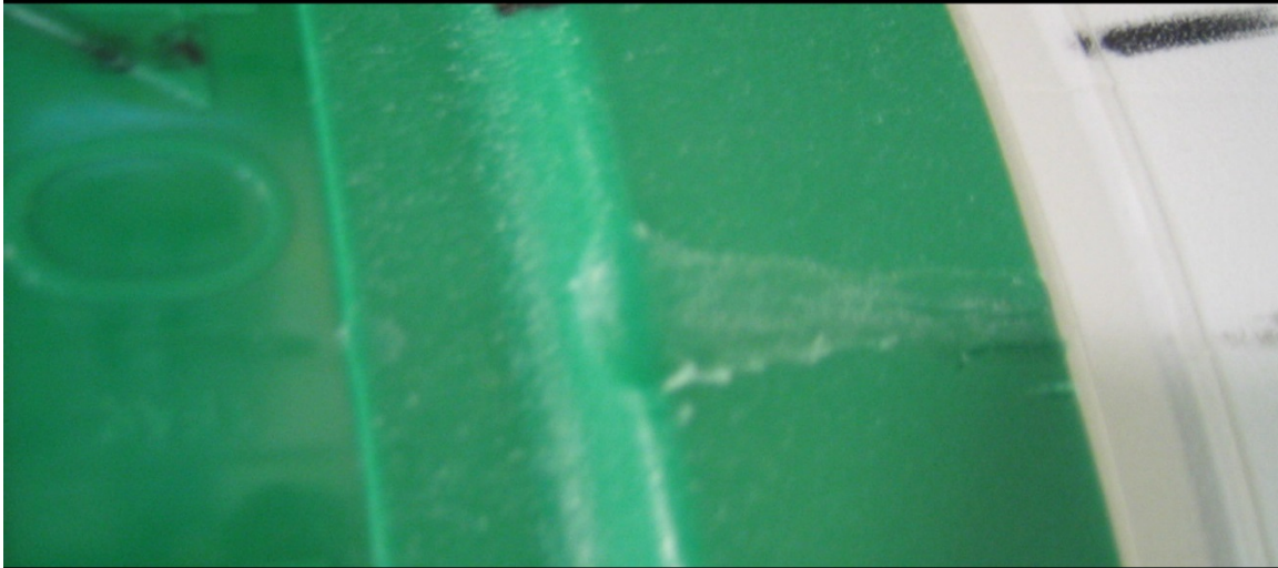
Figure 4 : Dommages subis suite à une chute horizontale, ce qui est le dommage le plus sévère pour ce type de bouteille à gaz. Si ces marques se trouvent à la partie cylindrique ou à la jointure entre la partie supérieure et inférieure de l'enveloppe la bouteille à gaz doit être retirée.
